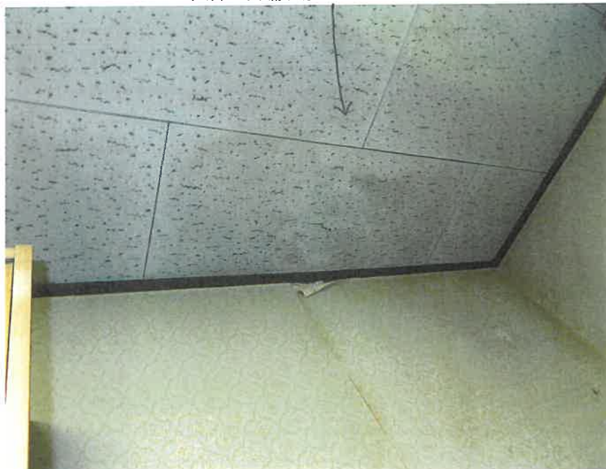
天井の雨漏り跡のようなシミ等と壁クロスの剥離
