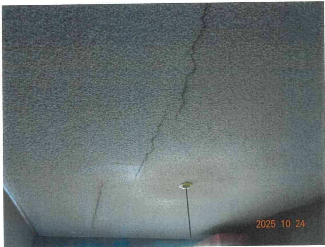
④北側和室の天井のひび割れ
