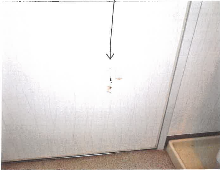
ドアの損傷
