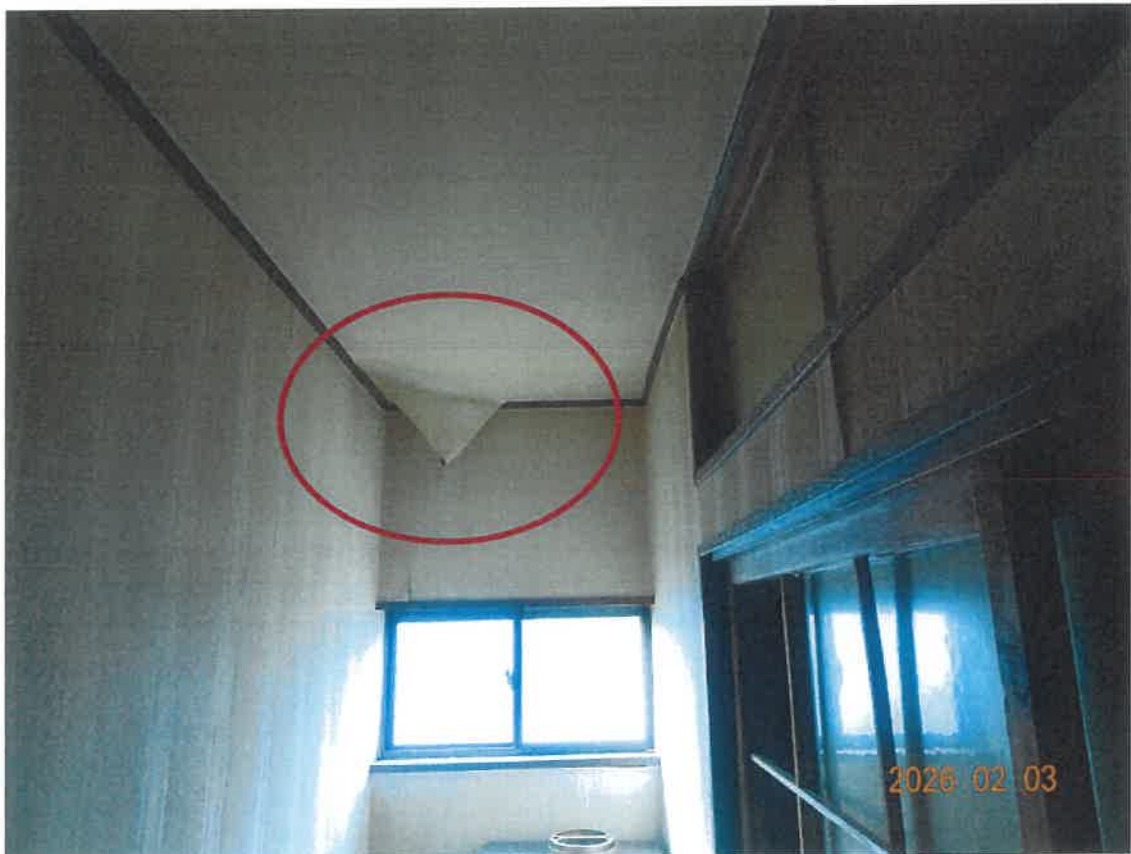
㉔ 2階廊下の天井の破損部分
