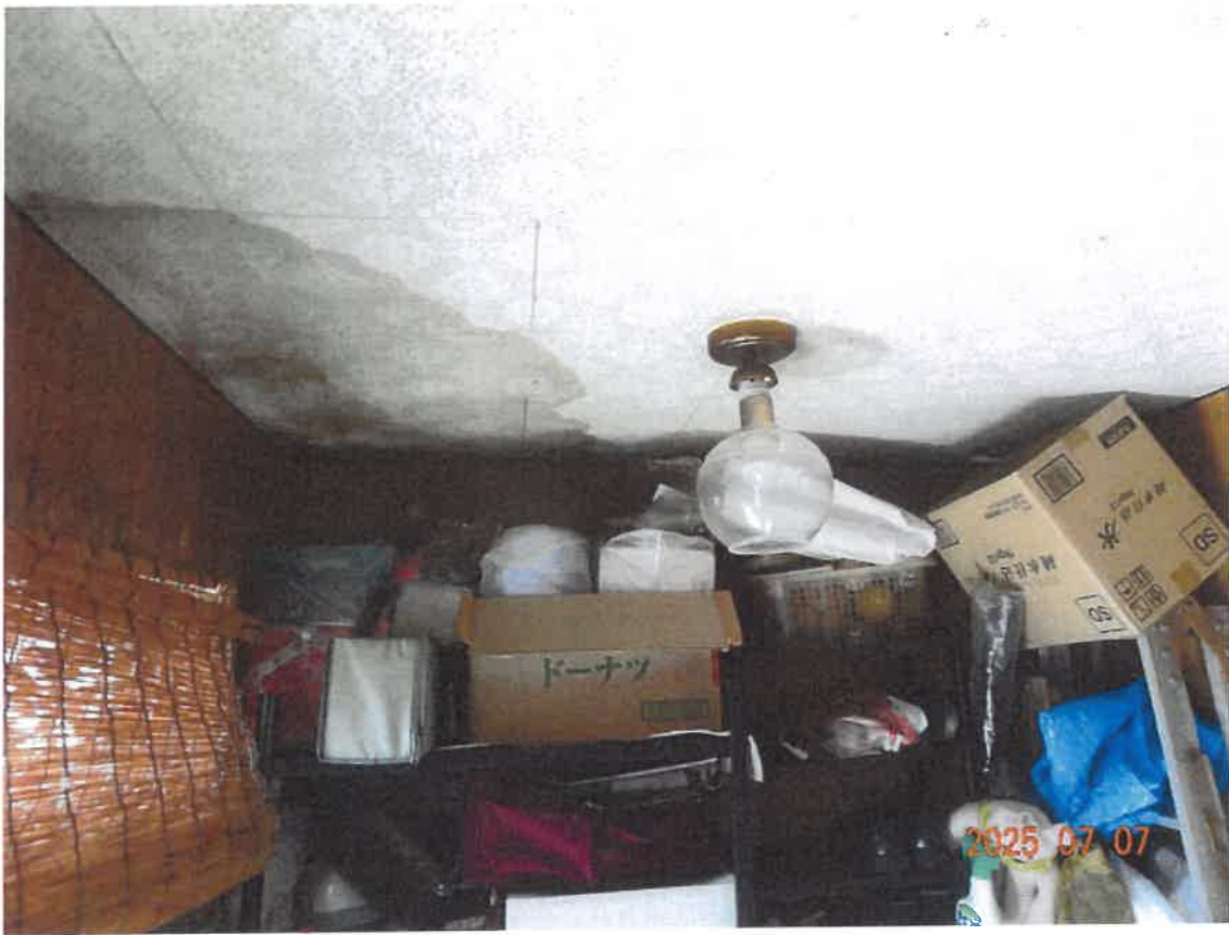
⑮玄関の天井の雨漏りによるものと推測されるしみ
