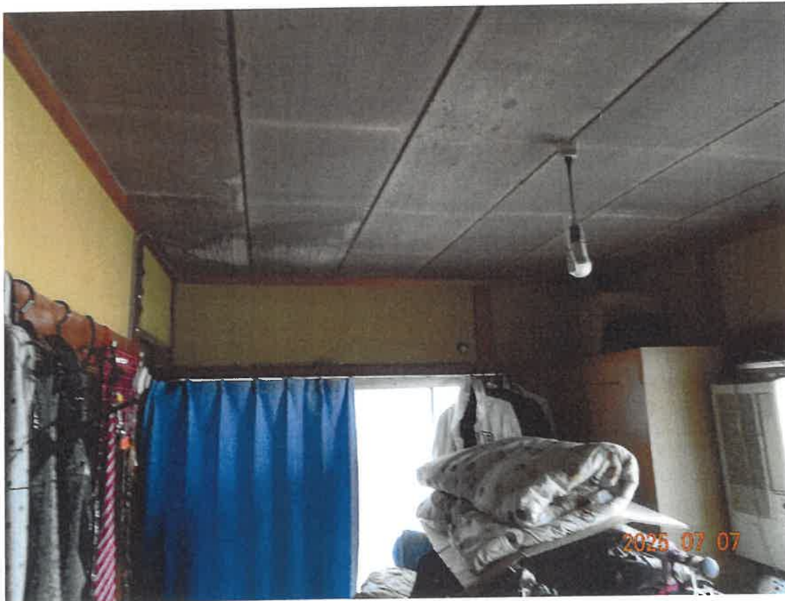
⑭ 2階天井の雨漏りによるものと推測されるしみ
