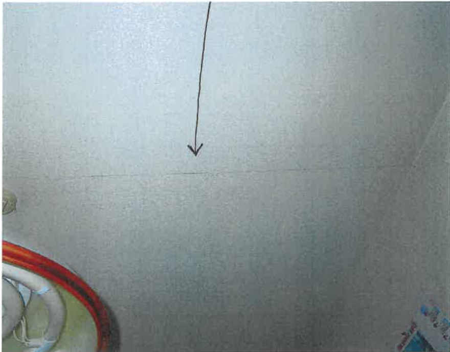
天井に走る亀裂の線
