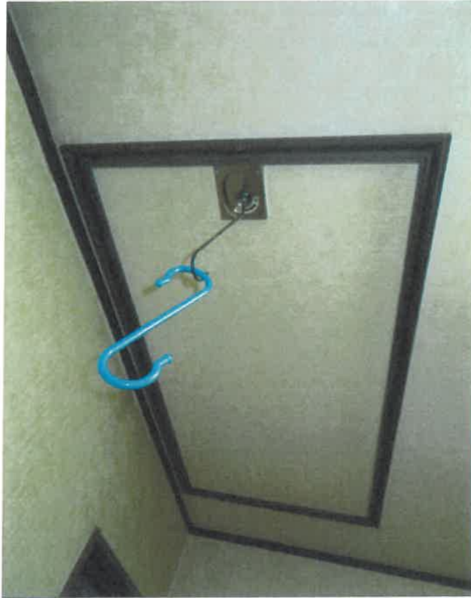
天井にあるロフトへの出入口
