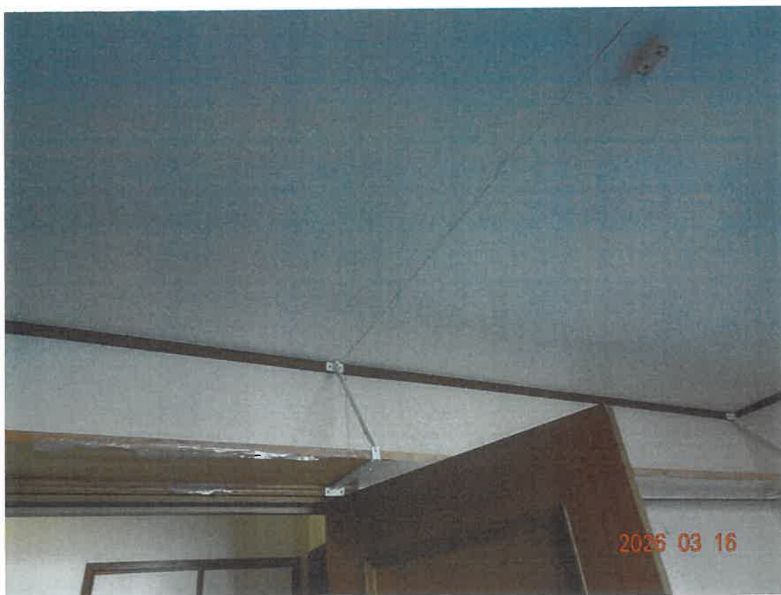
⑭ 壁と天井のひび割れ
