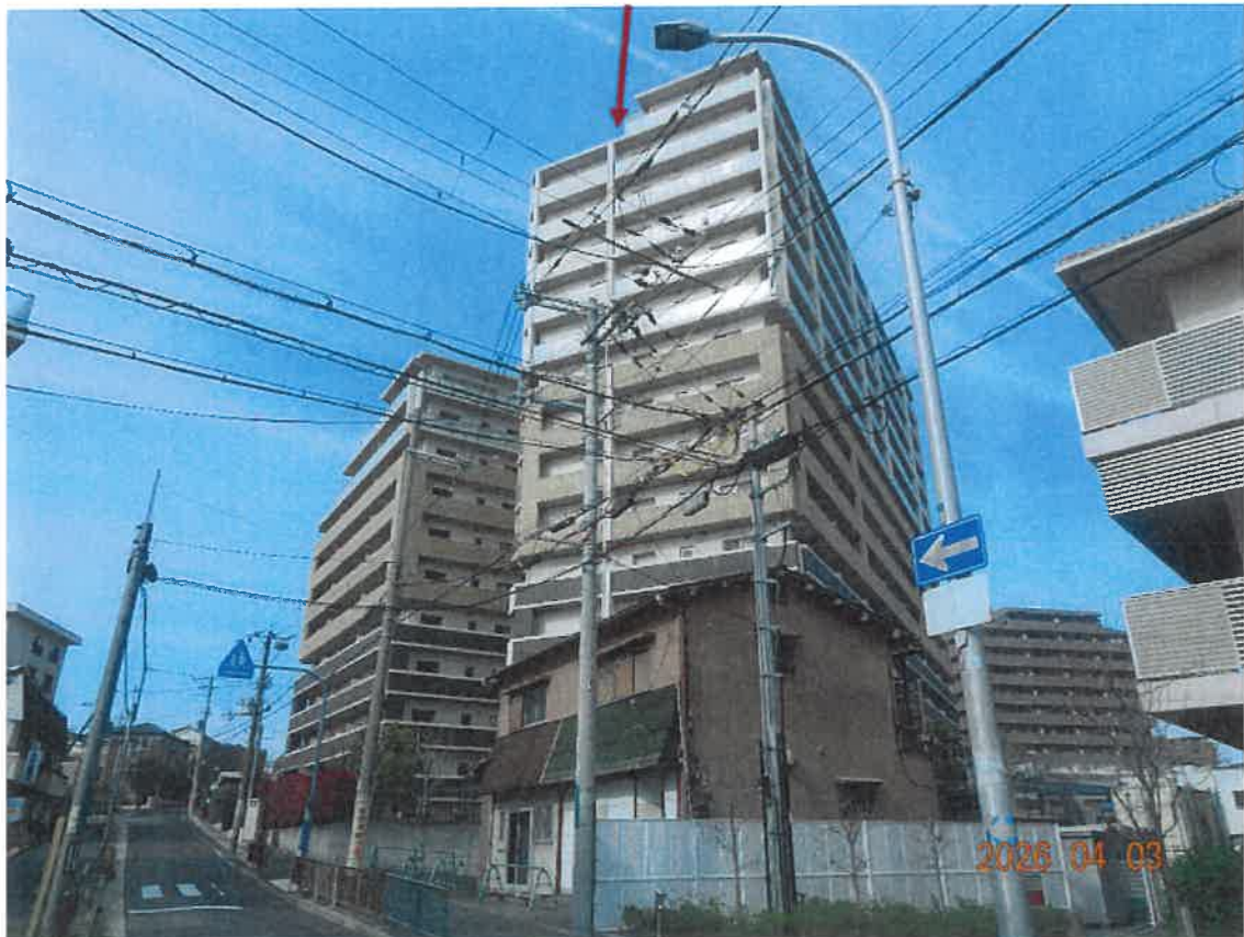
②目的建物が含まれるマンション
