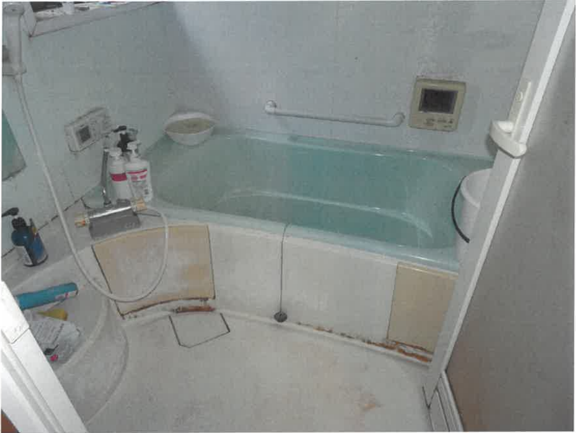
8 壁面の損傷
