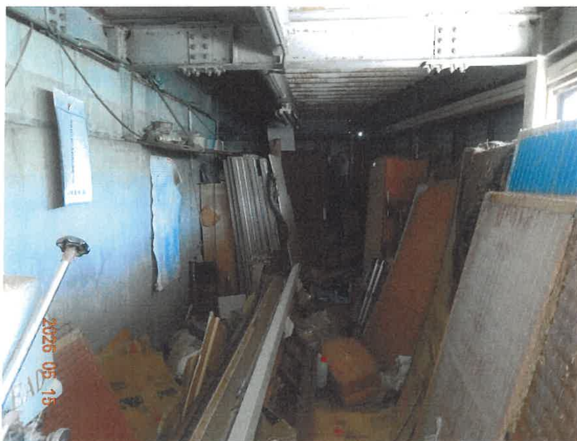
⑬敷地南側に設置された構造物の内部
