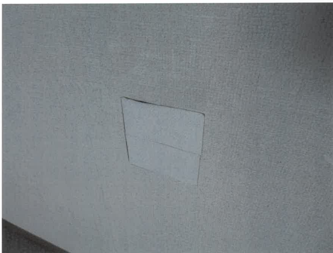
4 壁の損傷を修繕したと推測される部分
