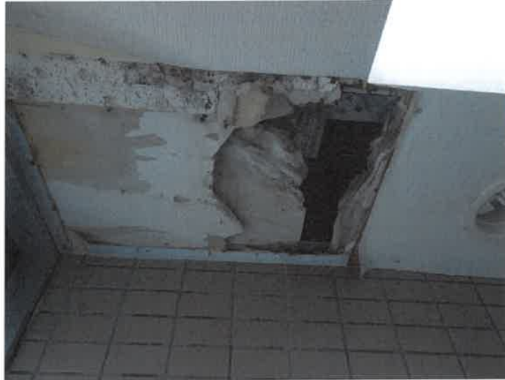
4 天井の破損（雨漏り）
