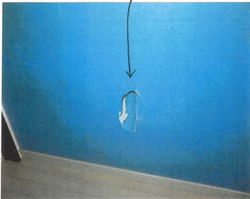
壁の損傷(穴)
