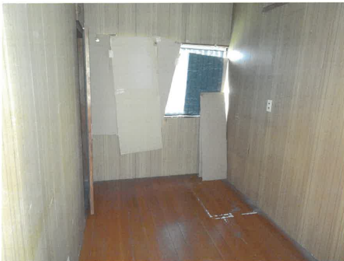
12 物入内部の壁面の損傷
