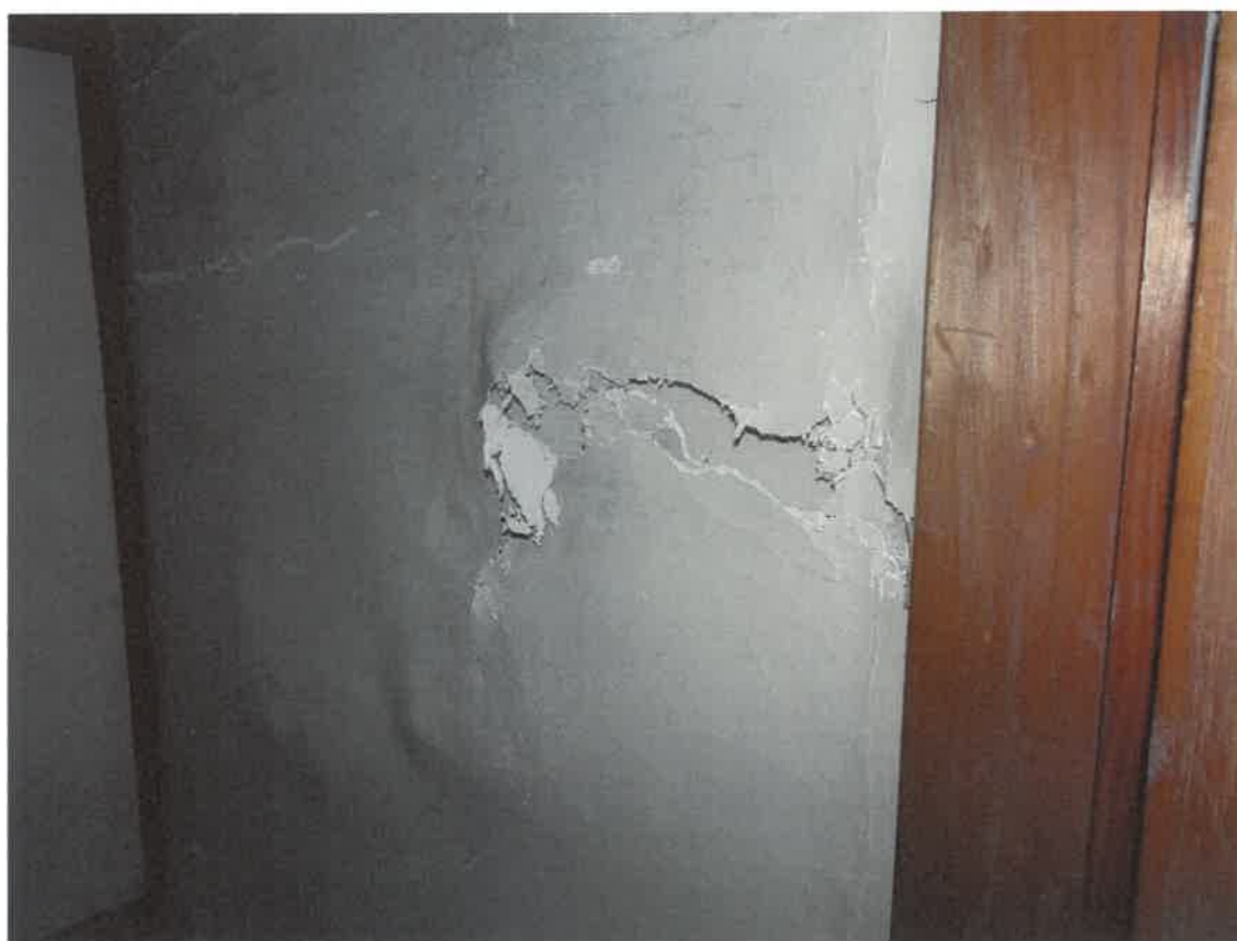
12 物入内部の壁面の損傷
