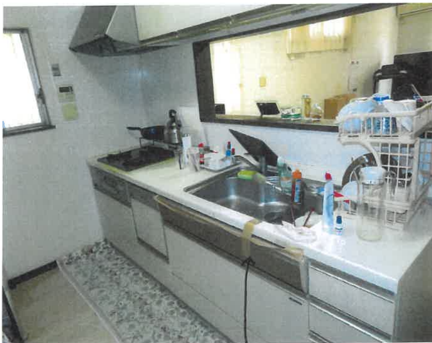
流し台下収納部の破損(テープで仮止め)
