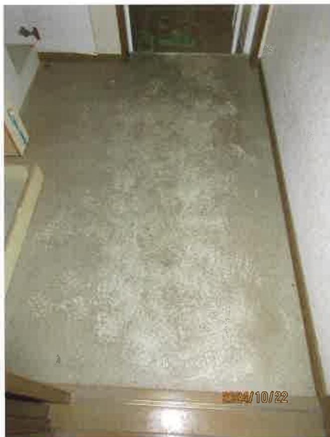
洗面所の床の状況
