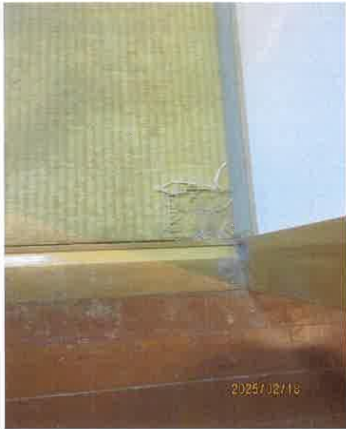
床面、畳の損傷 ( 11 枚目 )
