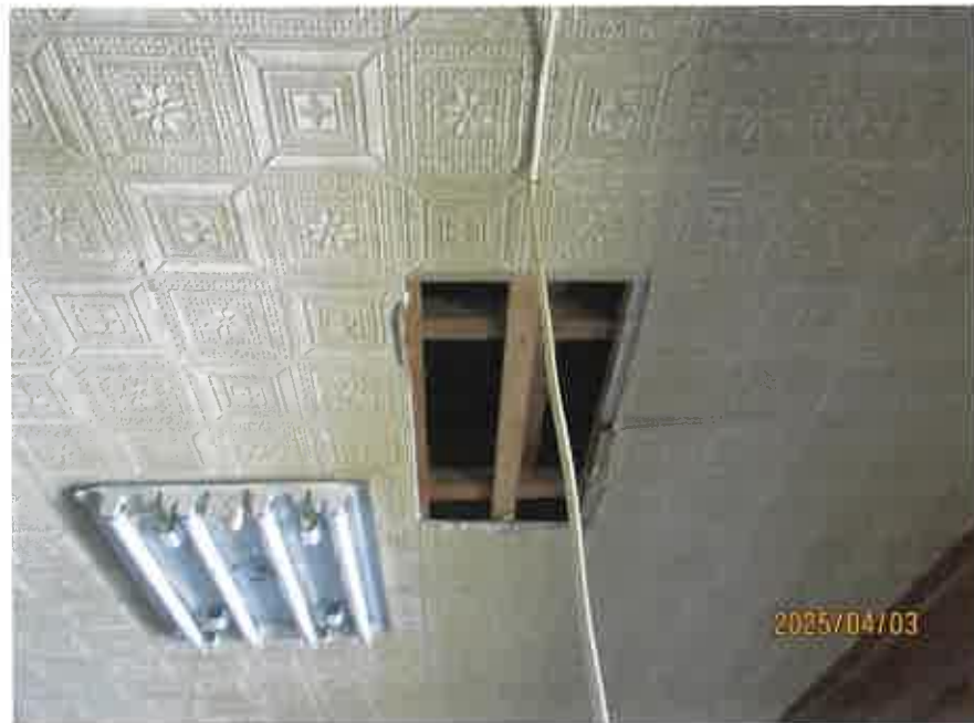
天井の損傷(雨漏り跡)
