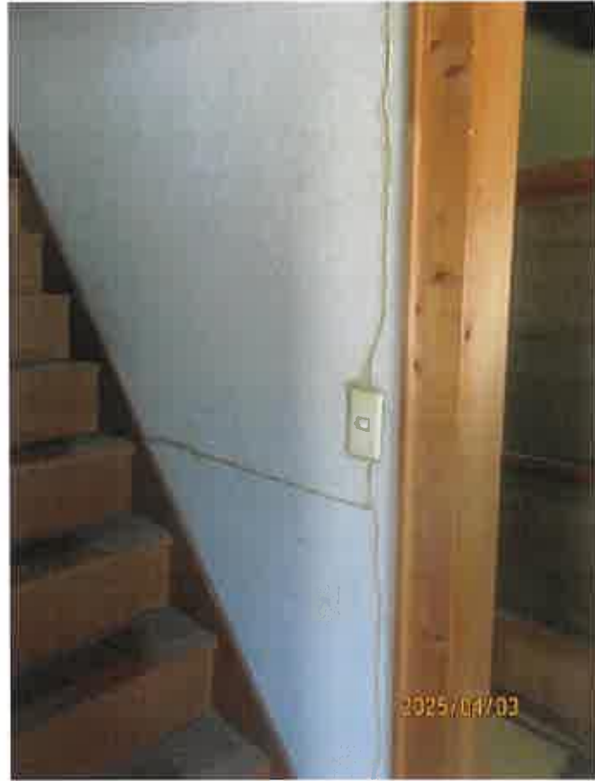
内壁の亀裂 ( 12 枚目 )
