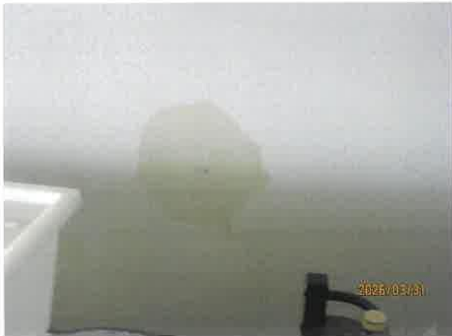
内壁クロスの損傷
