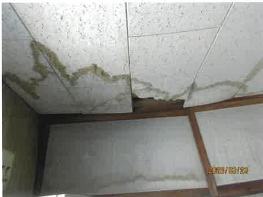
天井の損傷(雨漏り跡)
