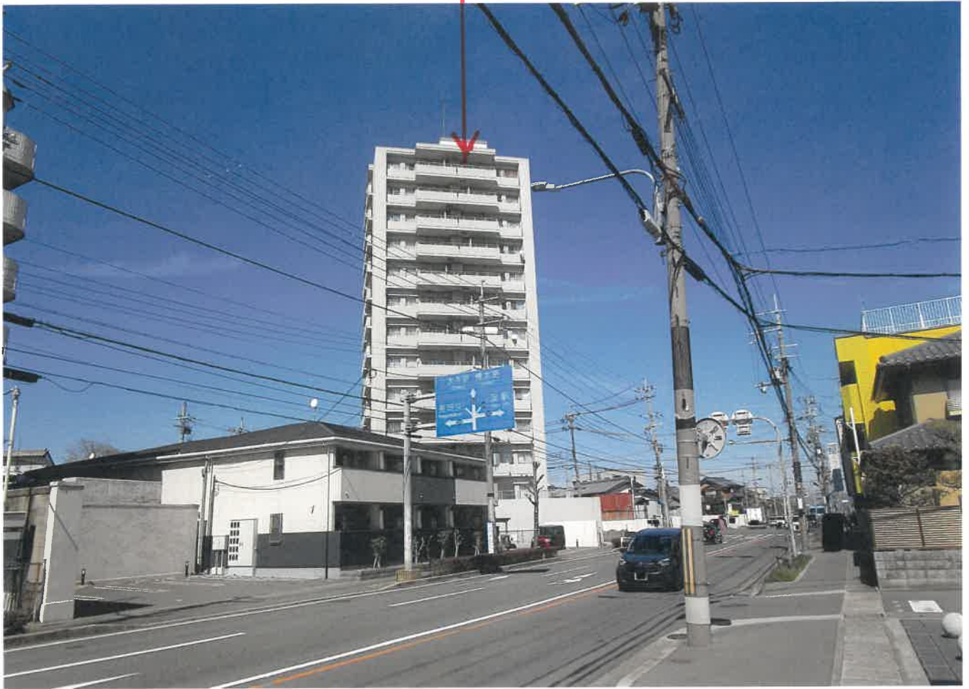
物件1の一棟の建物
