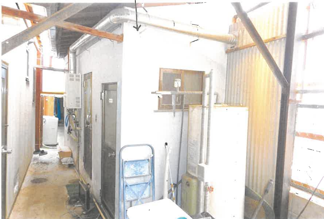
物件7附属建物1
