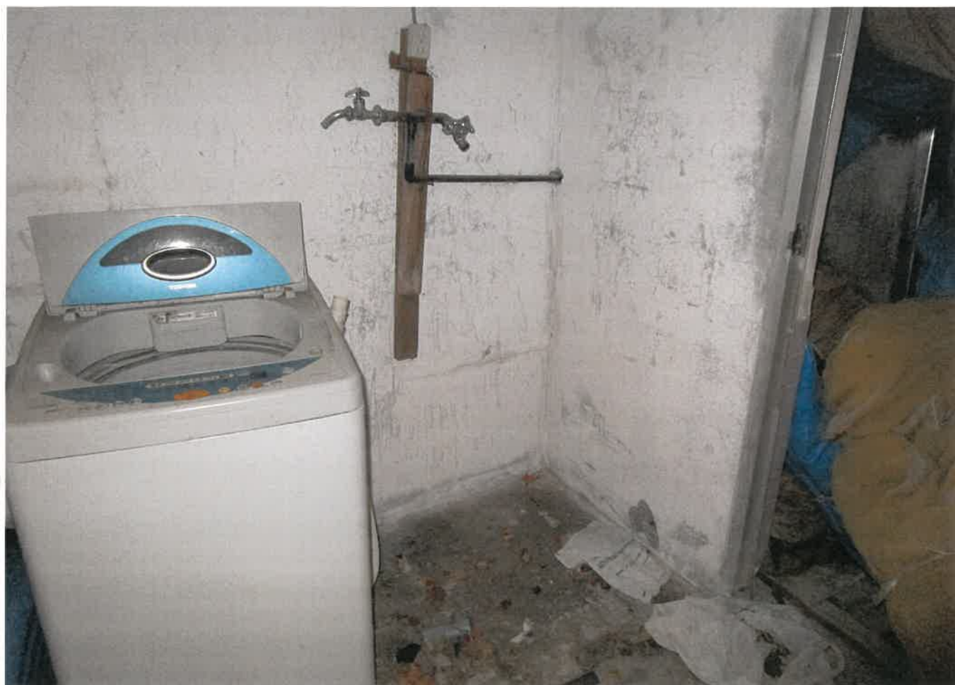
19 附属建物③の入口(西側)
