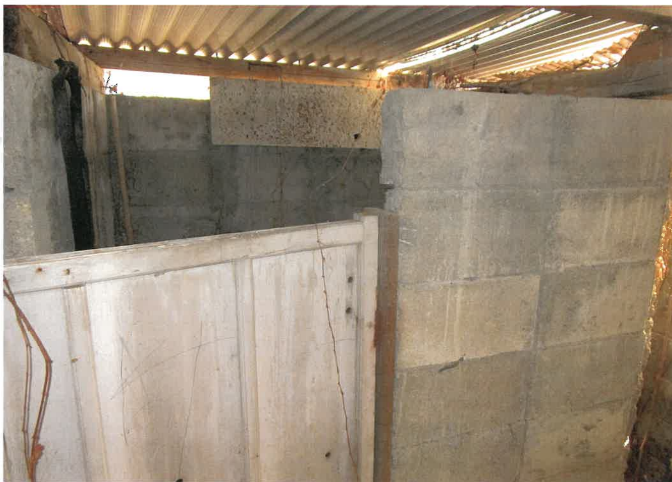
20 附属建物③の東側
