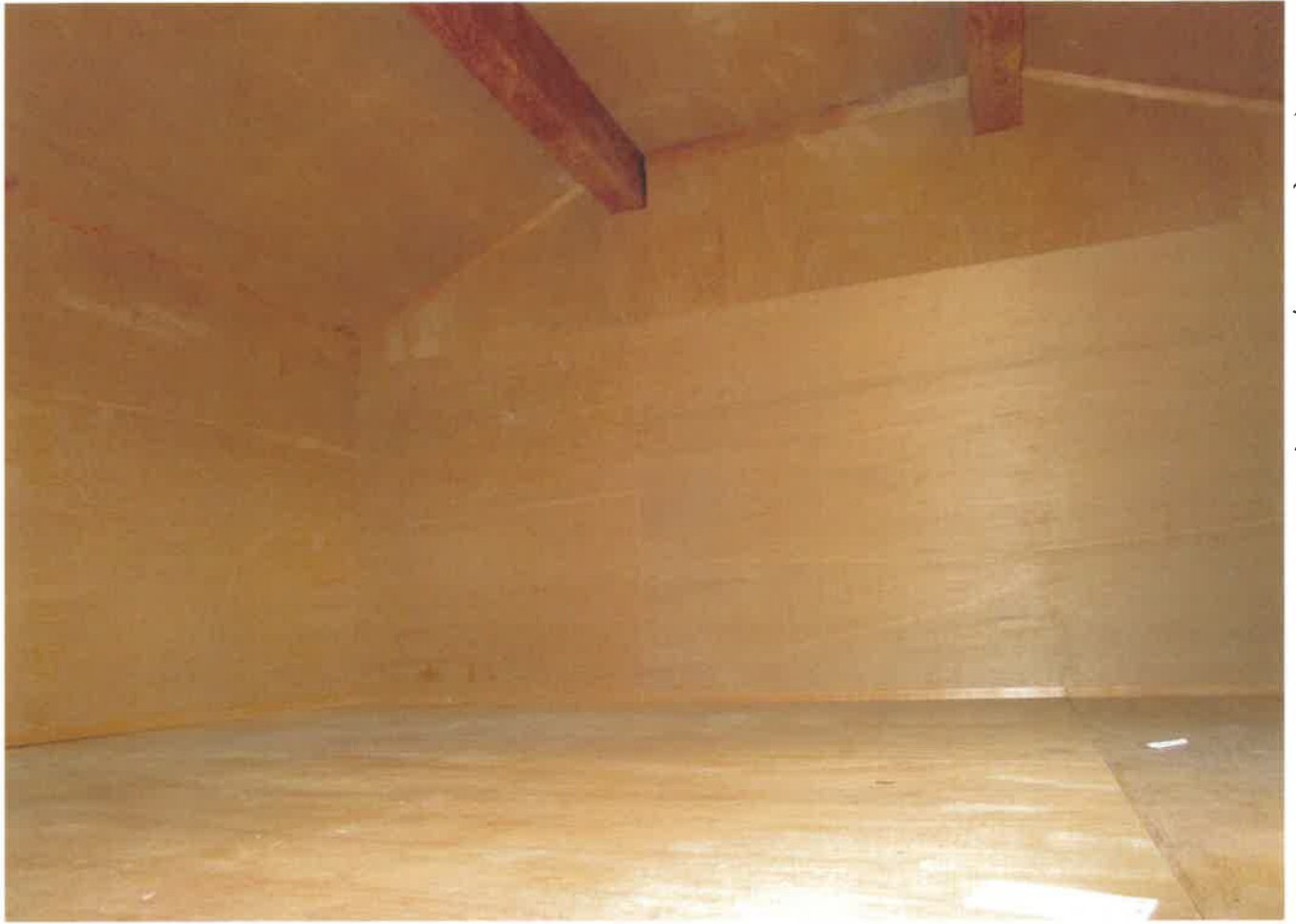
7 天井収納内部
