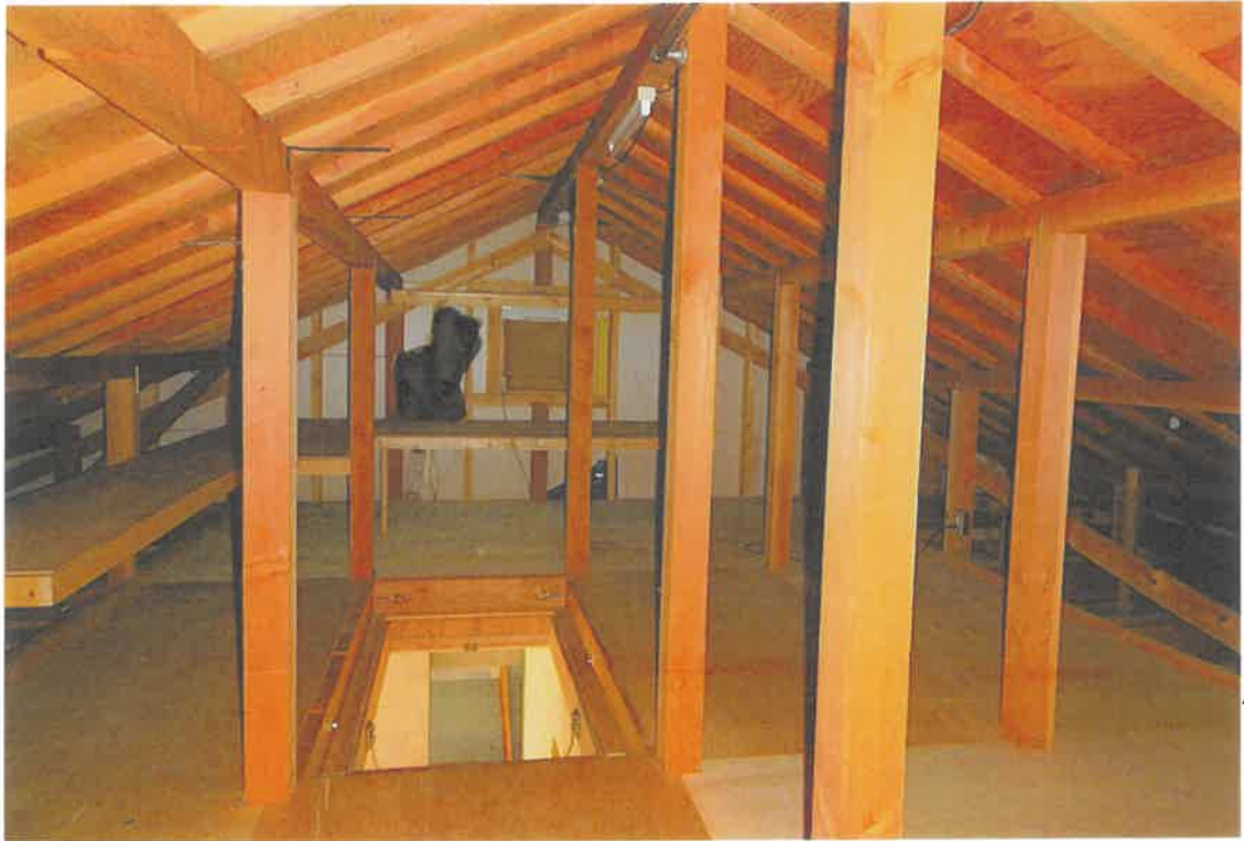
11 屋根裏収納部分（3階）
