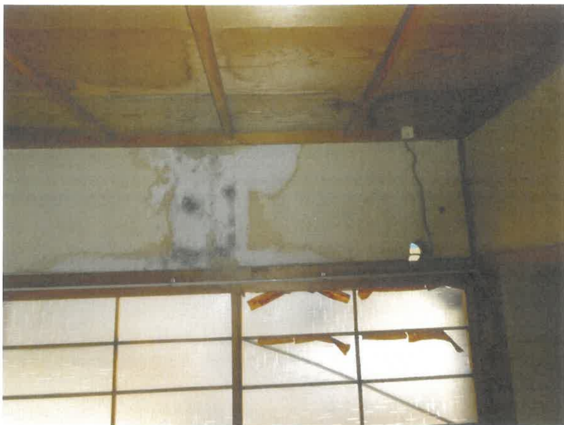
5 2階北側和室の北側の天井
