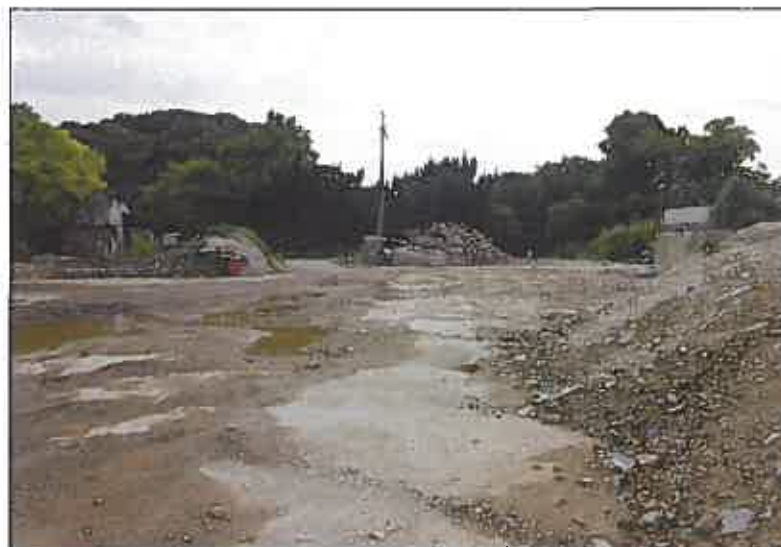
北西側からの撮影
