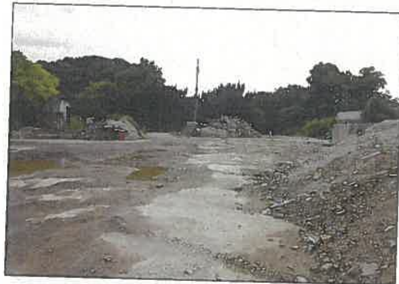
北西側からの撮影
