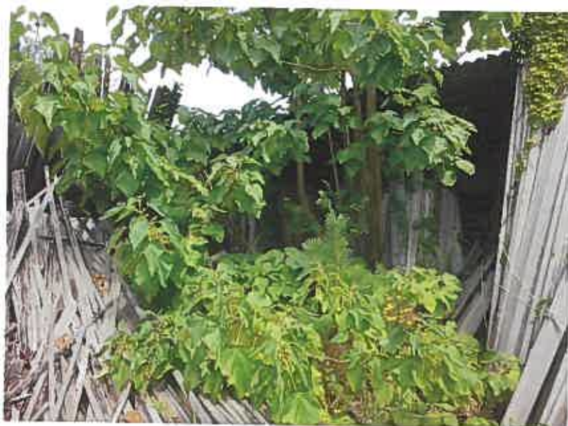
附属建物4 付近
