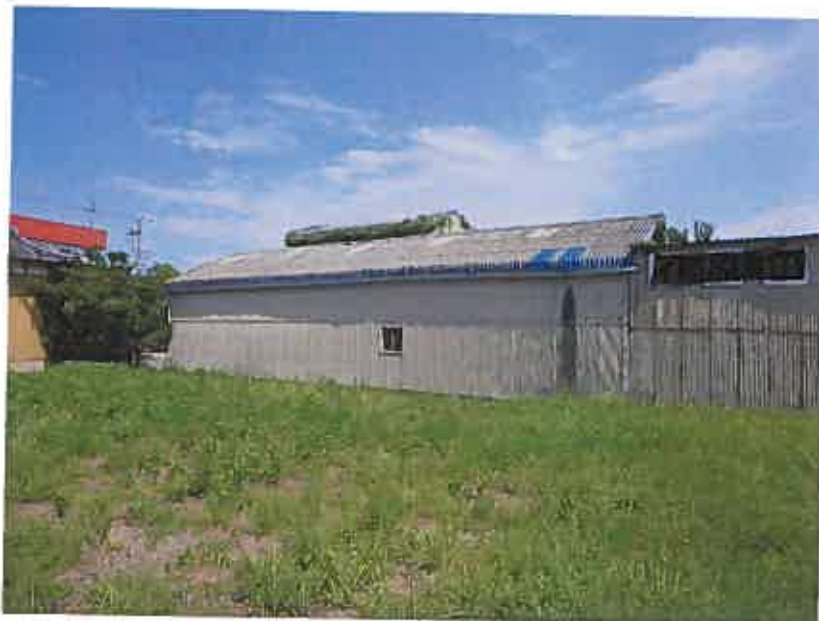
附属建物符号2 北西側より
