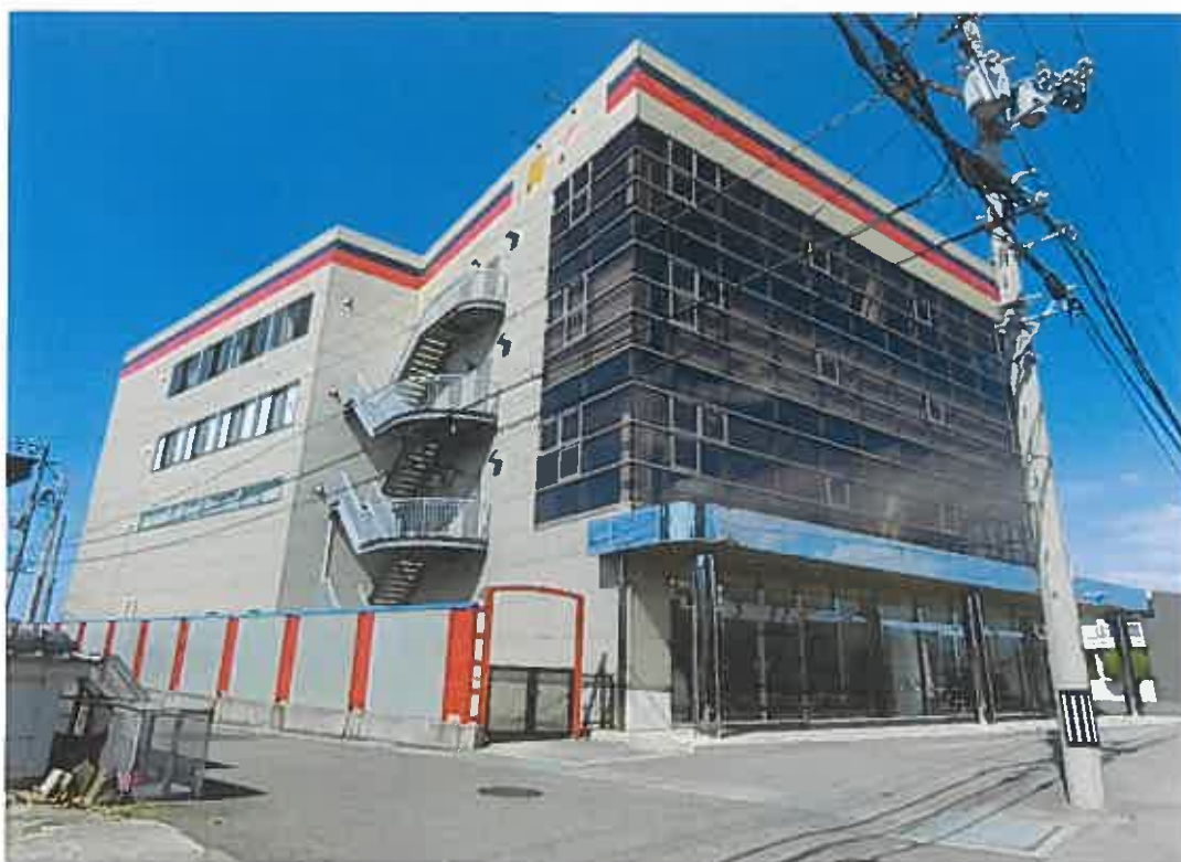
附属建物（符号1） 外観
