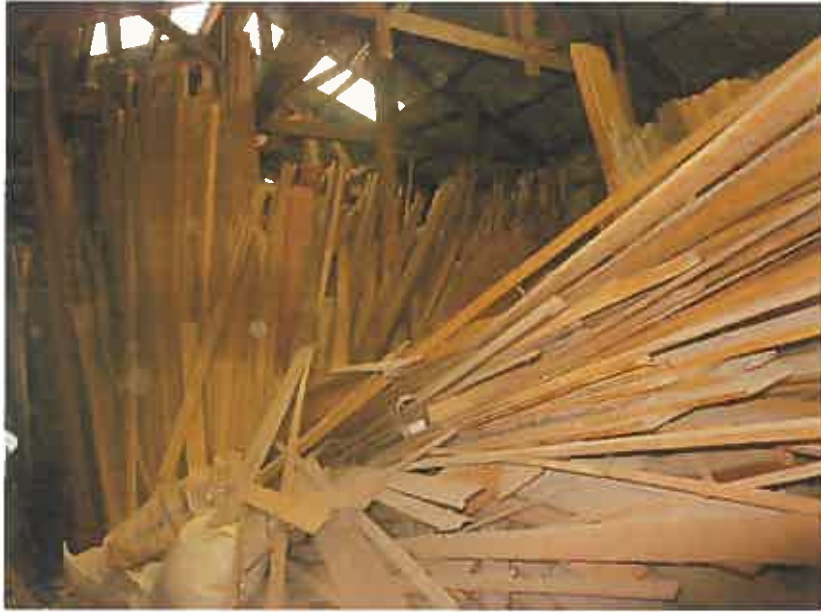
附属建物符号2 内部
