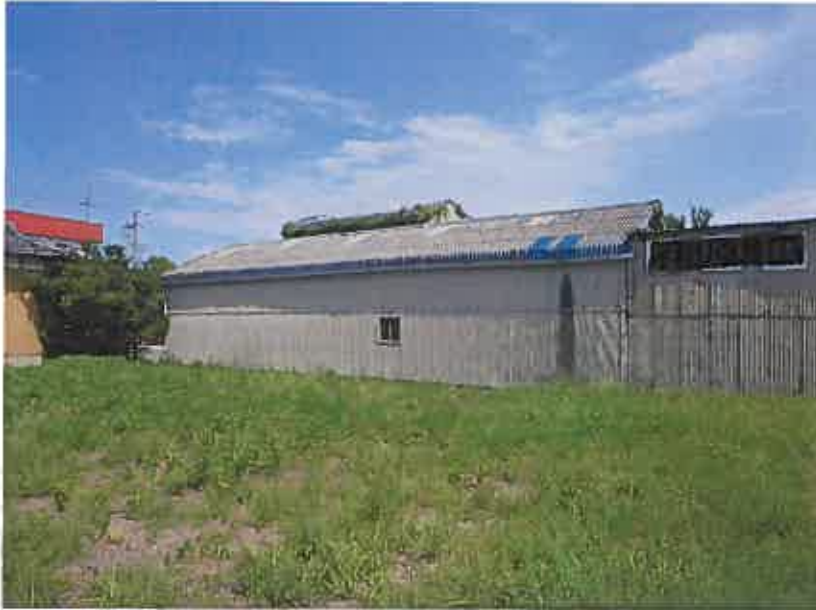
附属建物符号2 北西側より
