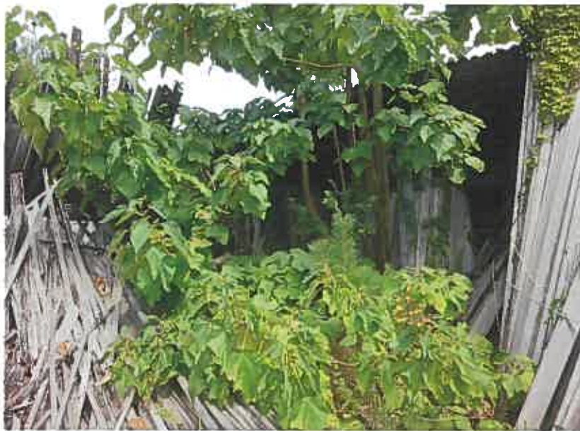
附属建物4 付近
