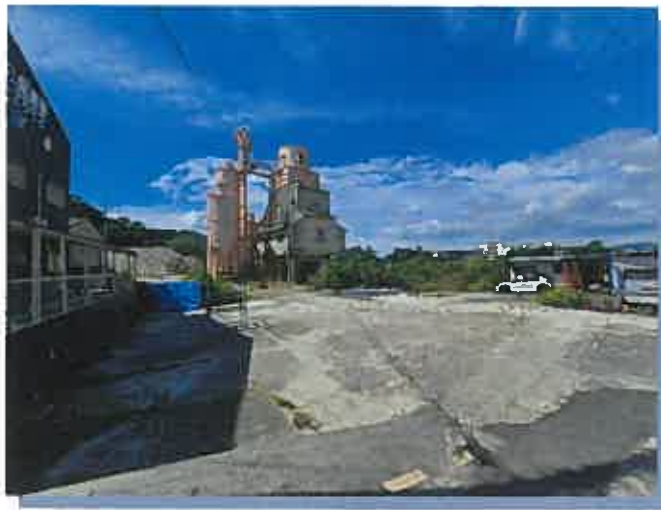
生コン工場（北東方より）
