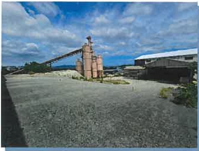
生コン工場（南東方より）
