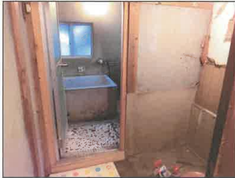
物件18の建物内部 (1階浴室)
