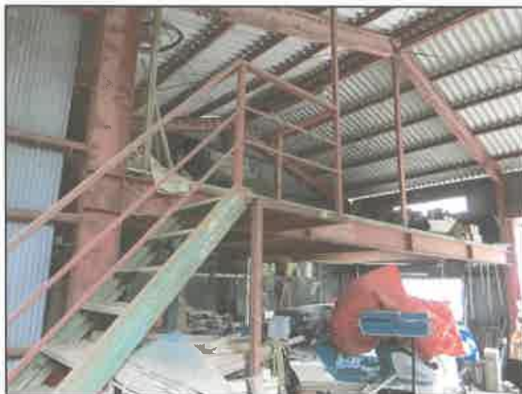
建物内部を撮影 (2 階部分)
