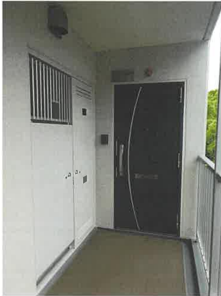
専有部分玄関付近
