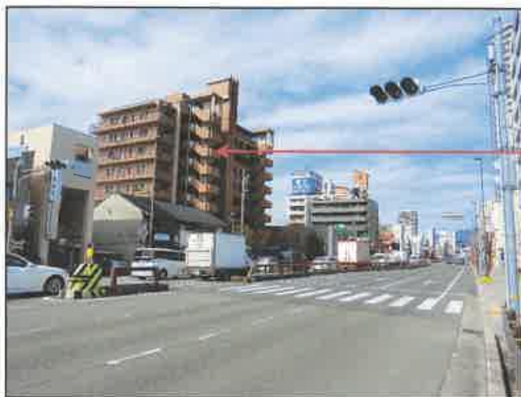
対象物件を含む 一棟の建物 対象物件を 北東方から撮影
