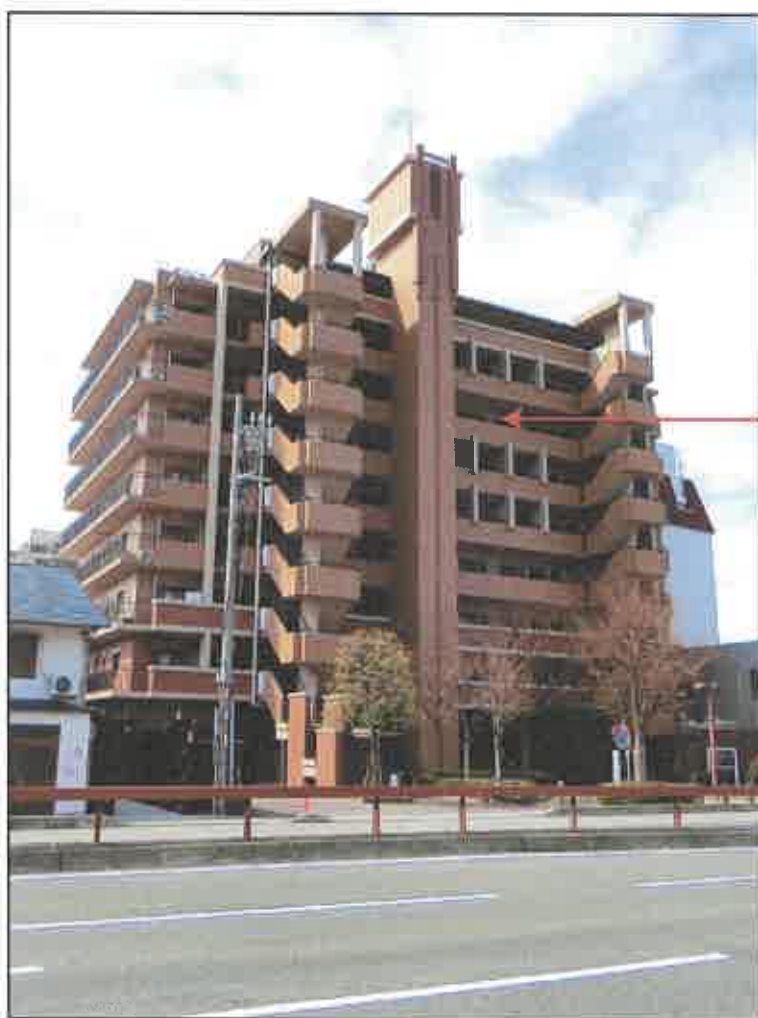
対象物件を含む 一棟の建物 対象物件を 北方から撮影
