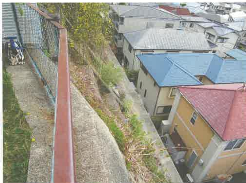
背面擁壁部分
