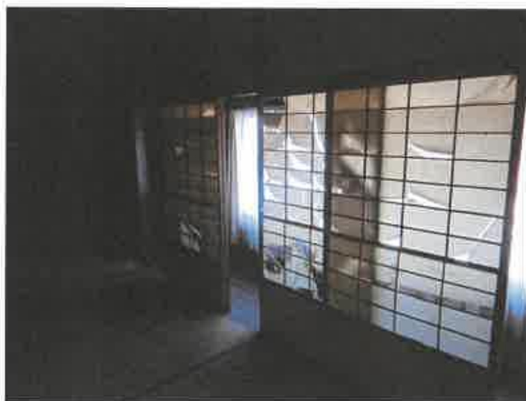
物件16の主たる建物 建物内部（2階）
