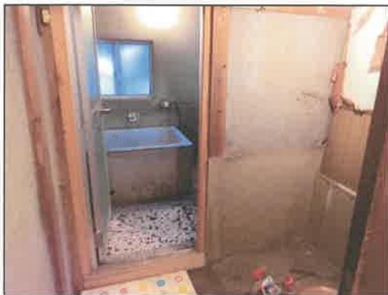
物件 1 8 の建物内部 ( 1 階浴室)
