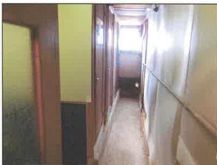
物件 1 8 の建物内部 ( 1 階便所)
