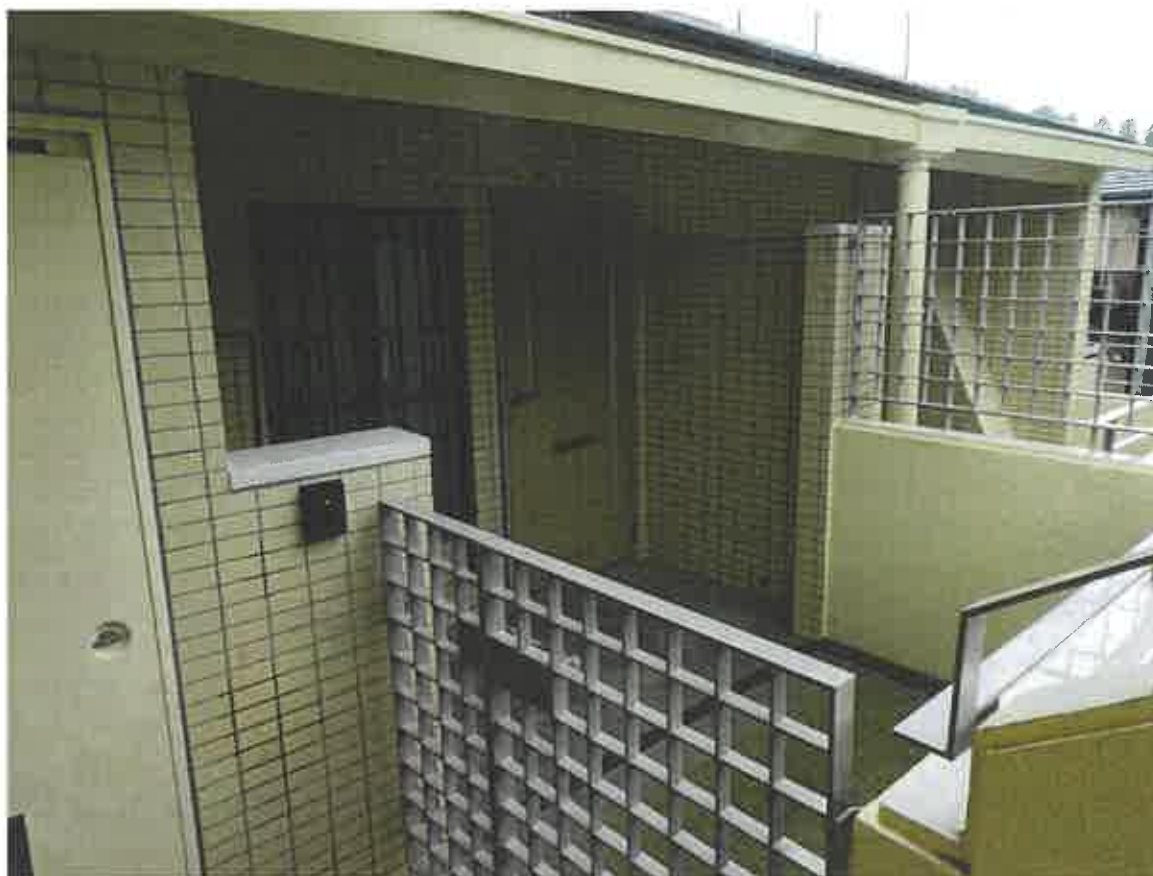
専有部分玄関付近
