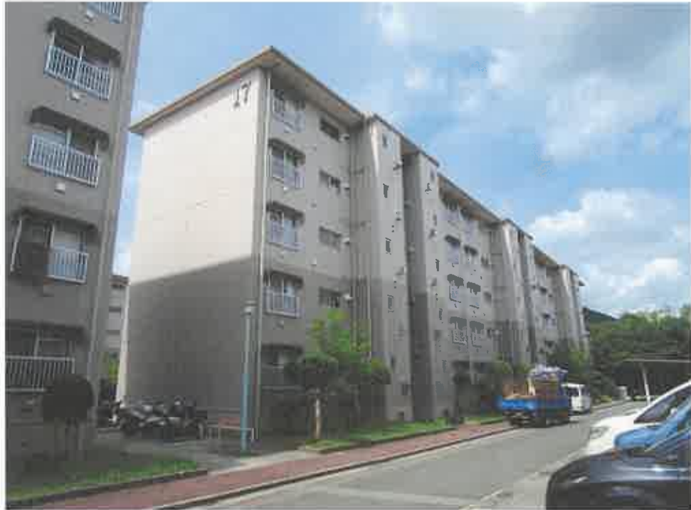
対象物件（物件1）を含む一棟の建物
