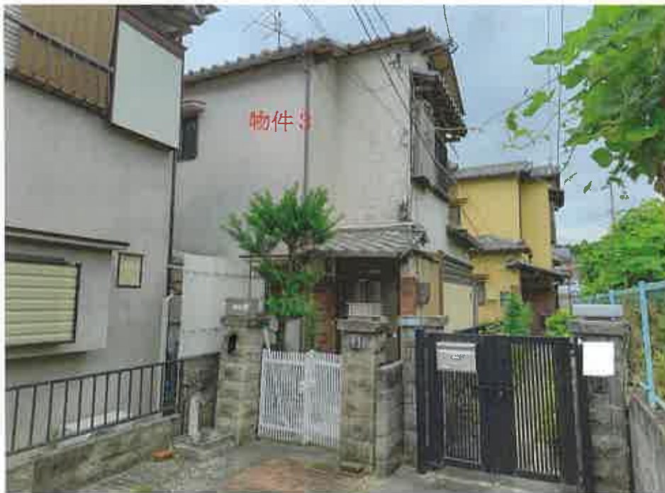
西方より（物件3近景）
