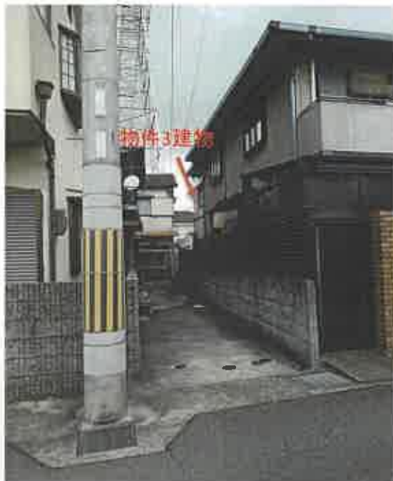
公道より物件3建物に至る通路
