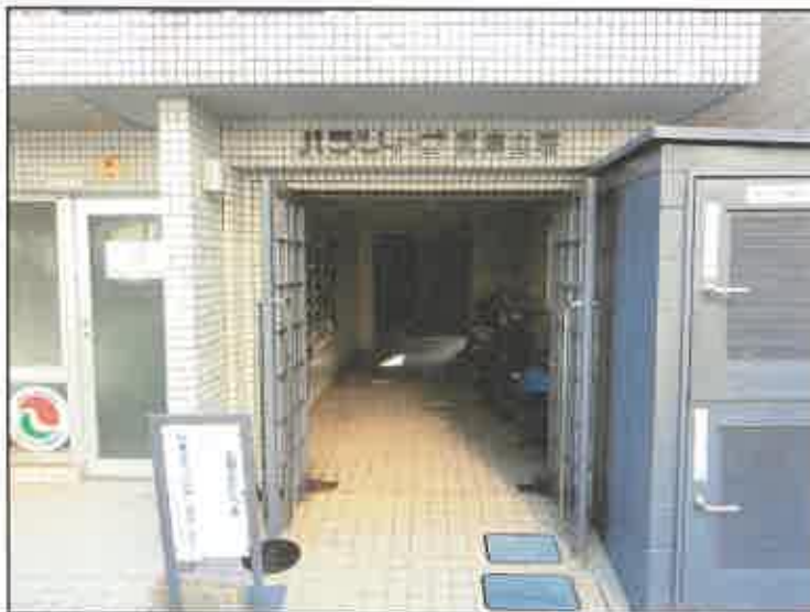
エントランス付近を撮影 (西北から撮影)
