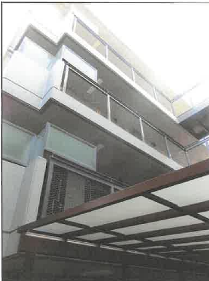
対象物件を含む 一棟の建物を 北東方から撮影
