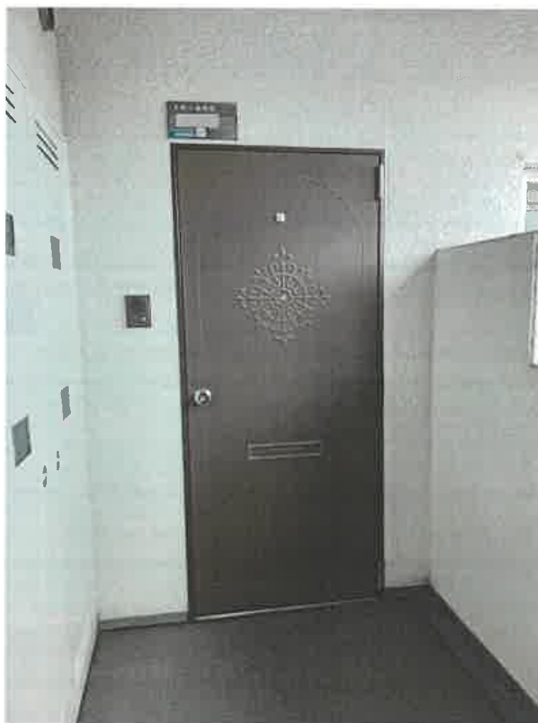
専有部分玄関付近
