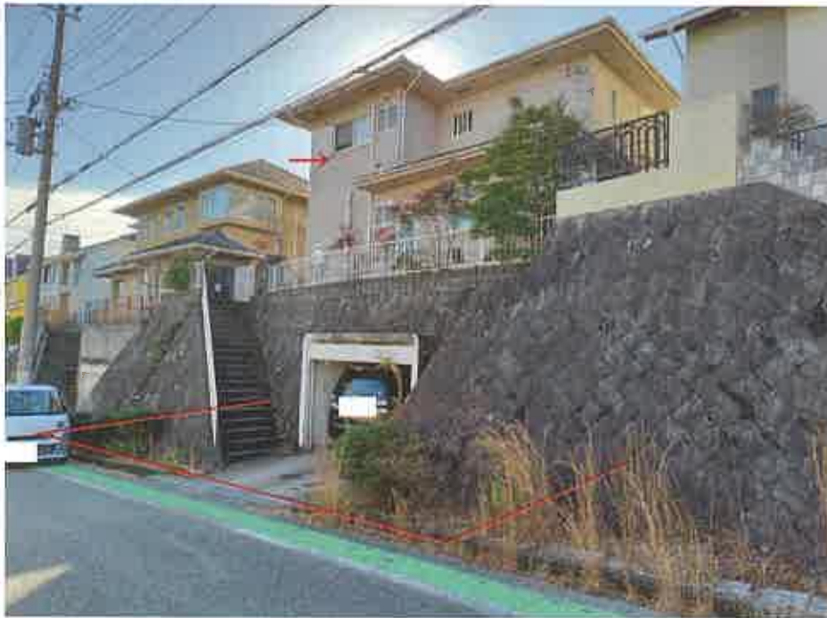
北東方より（物件1・2）
