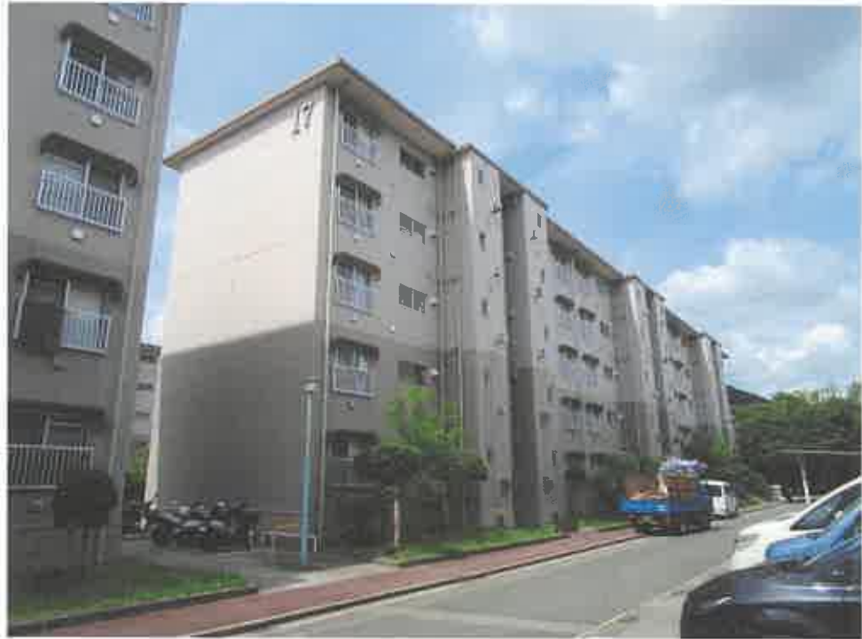
対象物件（物件1）を含む一棟の建物
