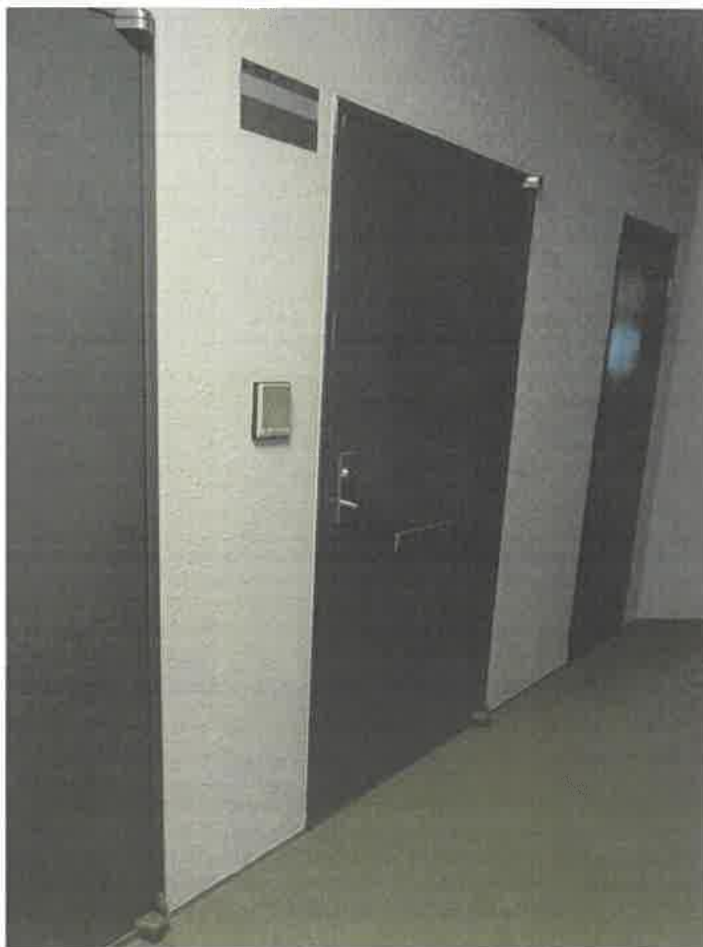
専有部分玄関付近
