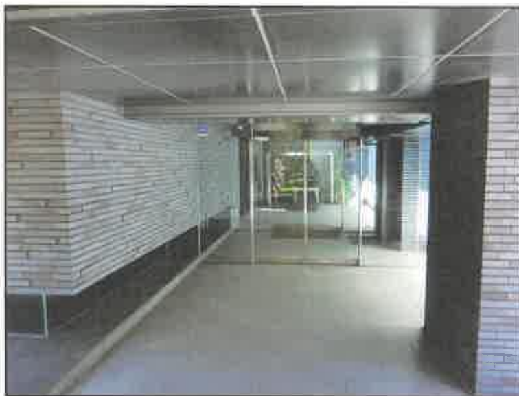
エントランス付近を 撮影
