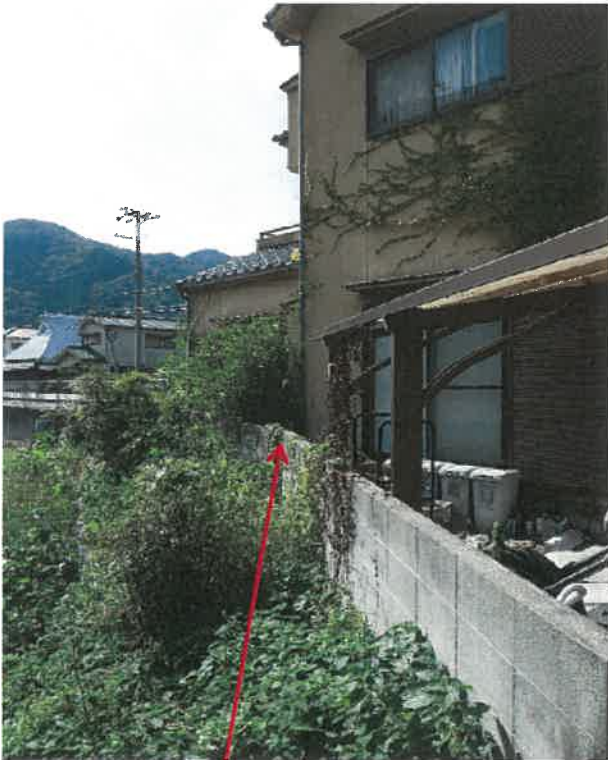
南東側ブロック塀の曲がっている部分
